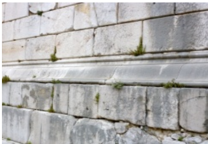
Bloc de pierres de grand appareil et larmier
